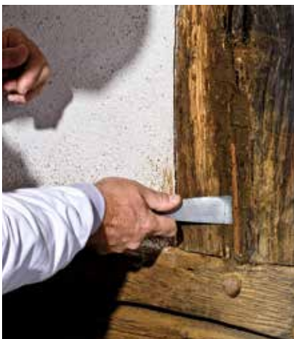
Schritt 4: Überschüssiges Material abnehmen.
