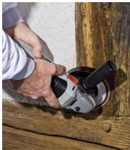
Schritt 5: Zur optischen Angleichung kann die frische Reparaturstelle mit einer 120er-Lamellenschleifscheibe bearbeitet werden.
