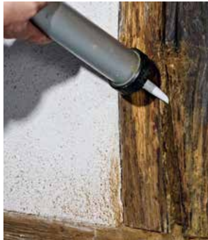
Schritt 2: Grundierten Riss mit Histolith Sanopas-Holzrisspaste füllen.
