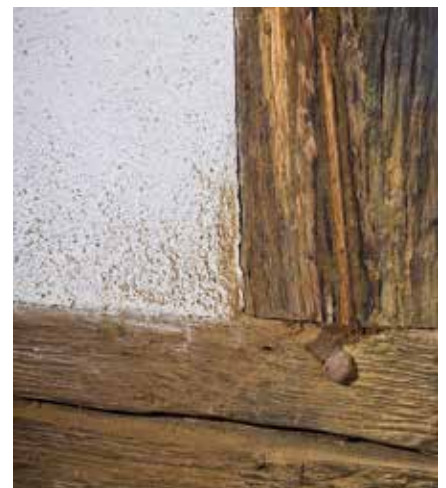
Schritt 6: Die fertige Reparaturstelle kann anschließend mit Histolith Leinölfarbe beschichtet werden.
