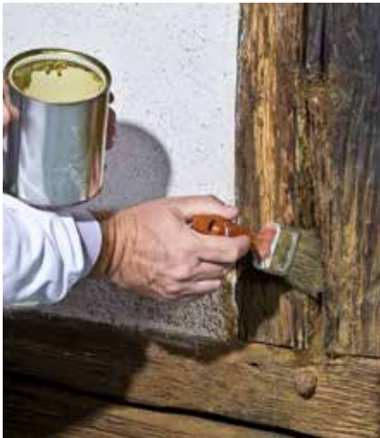
Schritt 1: Gereinigten Riss mit Histolith Halböl grundieren.
