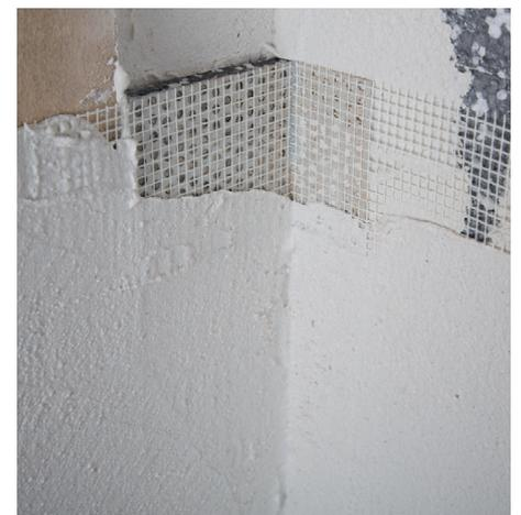
**Abb. 5** Ansicht und Einbausituation des Thermowinkels (Darstellungen von Caparol).
