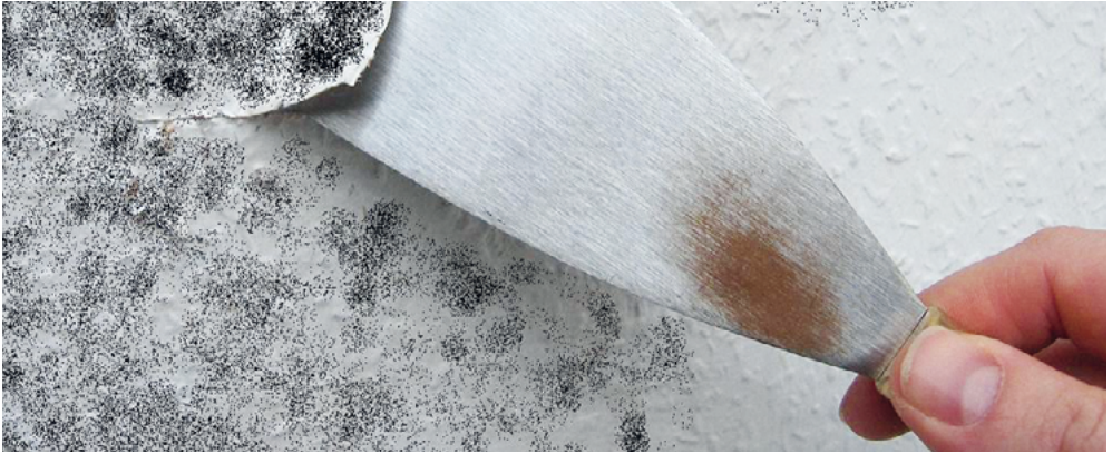
Gerade Neubaufuchte kann in den ersten Jahren nach Bezug dem Schimmel die notwendige Lebensgrundlage liefern.
