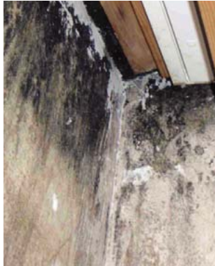
Geometrische Wärmebrücken führen häufig zu Schimmelbildung im Eckbereich.
