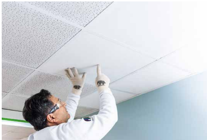
Formstabil: Eine Fixierung des RasterFiXX-Renovierungsvlieses ist nicht notwendig.
