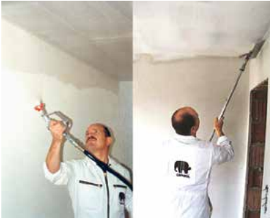
Verlängerungshilfsmittel erleichtern eine Deckenbeschichtung.
