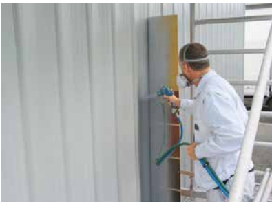
Spezielle Abdeckhilfen vermeiden, dass Spritznebel auf schon beschichtete Flächen gelangt. Dieses ist gerade bei Effektbeschichtungen zu beachten.
