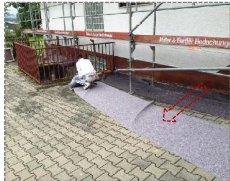
Dadurch ist der Abdeckungsaufwand im Dachbereich Außen und Innen gegenüber Rollen und Nespri zeitlich und mengenmäßig höher. Hierzu muss Kip Gewebe-Masker zusätzlich mit Klebeband an den Kanten und an dem Wanddeckenanschluss fixiert werden:
