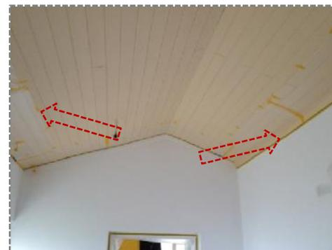
Im Gegensatz dazu wird bei den farbnebefreien Applikation Rollen und Nespri Kip Papier-Masker benutzt. Dieser ist wesentlich schmaler und muss nicht zusätzlich mit Klebeband an dem Wanddeckenanschluss fixiert werden:
