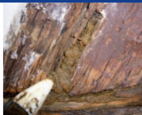
Schadhaftes Altholz untergrundschonend entfernen, Rissflanken reinigen und mit Halböl grundieren. Material mit schmalen Spachtel oder mit Handdruckkartusche satt in den Riss einfüllen. Überquellendes Material oberflächenbündig mit dem Spachtel abnehmen.
