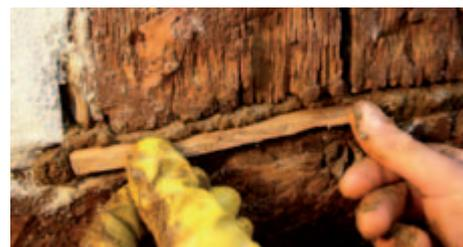
Bei Rissen mit einer Breite von mehr als 1 cm wird zusätzlich ein artgleiches Holzstück mit Histolith Sanopas-Holzrisspaste eingedrückt.
