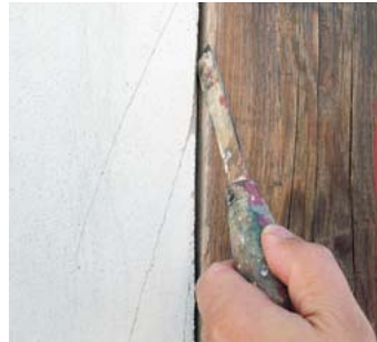
Lösen Mörtel entfernen
