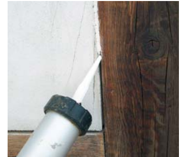
Fuge mit Histolith Kalk-Rissfüller füllen
